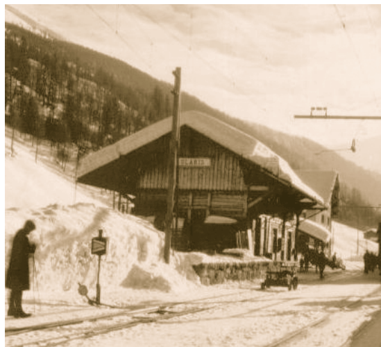
DAVOS GLARIS STATION NACH DER ELEKTRIFIZIERUNG
