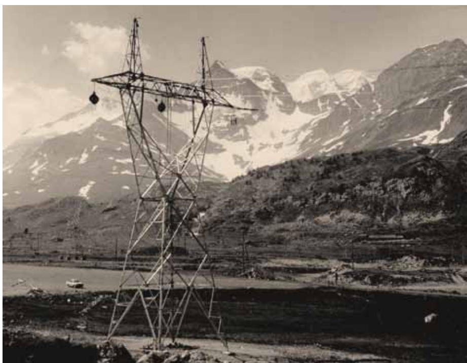
LEITUNGSBAU AM BERNINA
